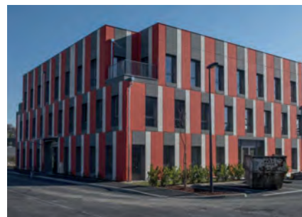
Grand Lyon Sud Ouest
